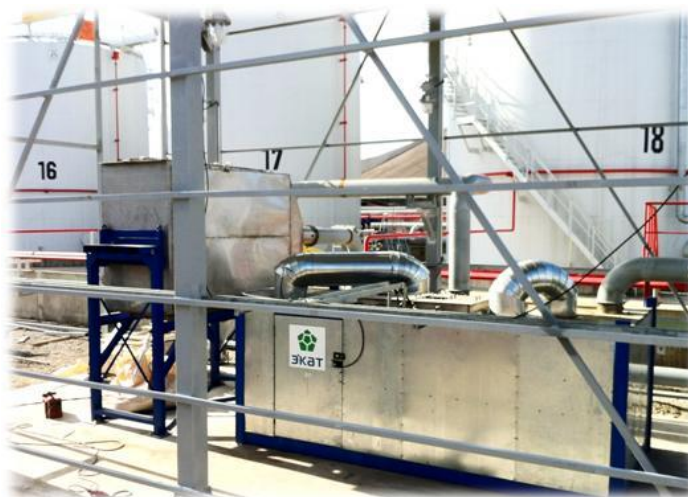
Рис. 3. Общий вид термокatalитической установки очистки газовых выбросов
